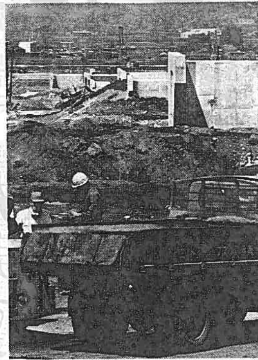
着々進む東名道路工事—伝法中折で—
