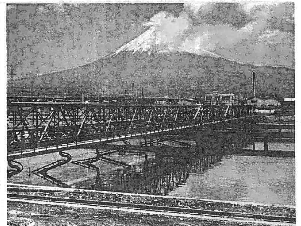
沼川下流に建設された汚泥処理プラント 日本食品化工東側
