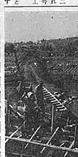
急ピッチで進められる農道づくり(穴原町1丁目)
