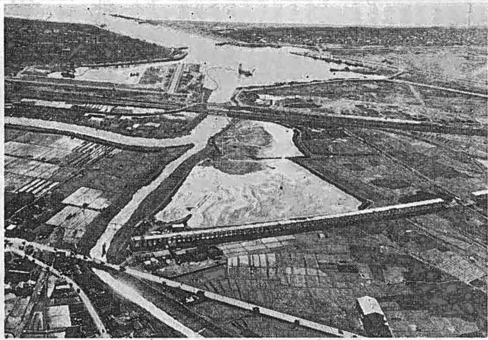
40年を完成目標に着々整備される田子の浦港(後方)と、巨大なパイプラインを使い海の土砂をすいあげて埋め立てをするN食品会社(前方)を空から望む
