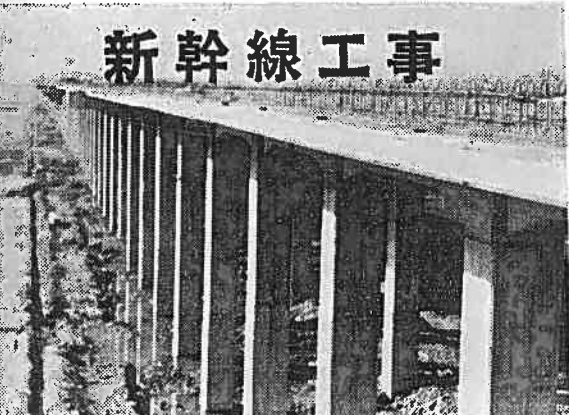
溜々進む東海道新幹線工事現場
