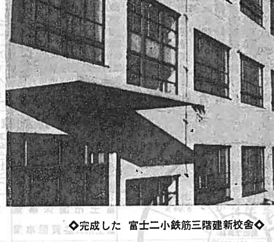
完成した 富士二小鉄筋三階建新校舎
